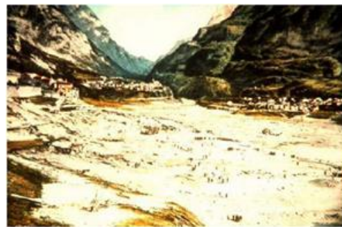
Figura 6. Vila de Longarone após o galgamento. Fonte: CBDB (2013).
