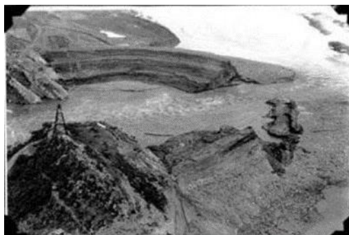
Figura 2. Barragem de Orós após a ruptura Fonte: Maestri (2012).
