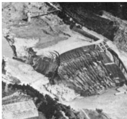
Figura 4. Barragem Euclides da Cunha após a ruptura. Fonte: CBDB (1982).
