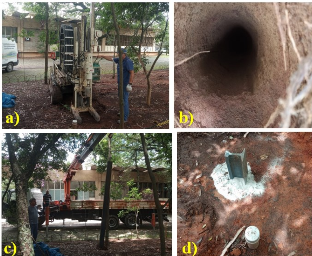
Figura 4. a) Equipamento de perfuração do terreno. b) Furo para inserção do trilho. c) Trilho de aço inserido na perfuração. d) Trilho de aço e perfuração revestida com areia; ao lado, tubo de PVC.
