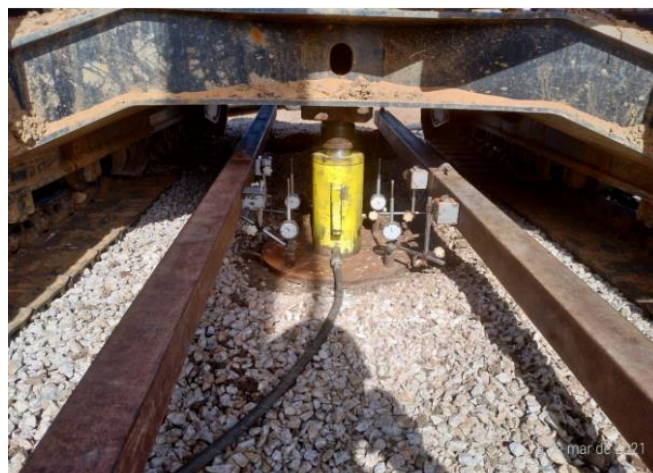
Figura 3. Detalhe da montagem da prova de carga em placa.
