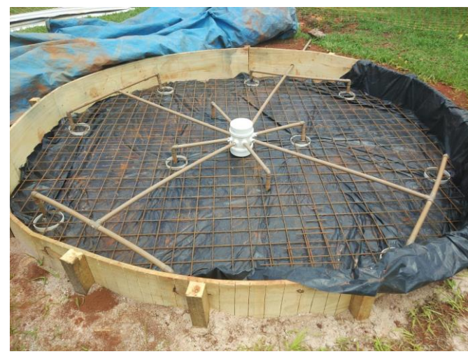
Figura 2. Modelo físico de referência antes da concretagem do radier.
