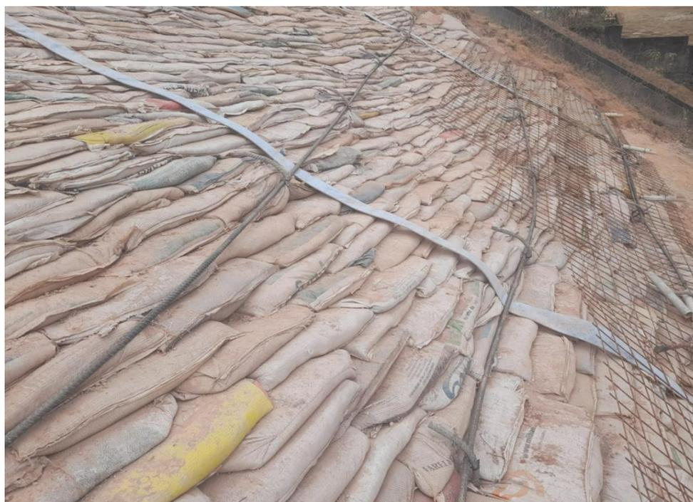
Figura 11. Grampos e barras de travamento instalados na sacaria
