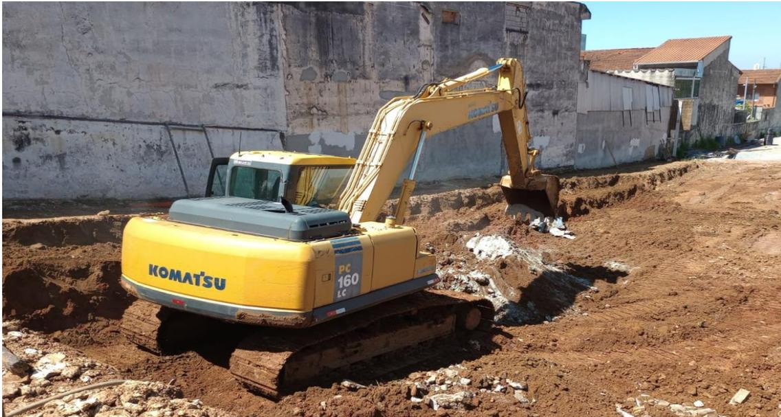
Figura 8. Mistura de solo com cimento sendo realizada de forma mecanizada
