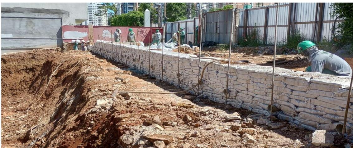
Figura 10. Esperas deixadas no local onde serão executados os grampos sub-horizontais
