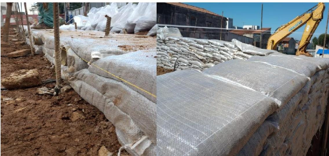
Figura 9. Linha de pedreiro sendo utilizada para garantir o alinhamento
