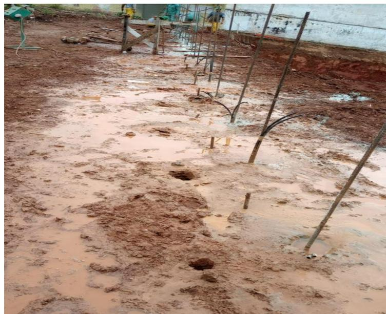
Figura 6. Execução dos grampos da face interna
