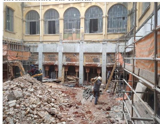
Figura 8. Estacas mega apoiando a fachada, com vigas e pilares do subsolo executados.
