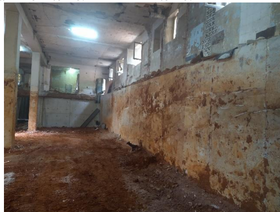
Figura 4. Subsolo interno na cota final de escavação.
