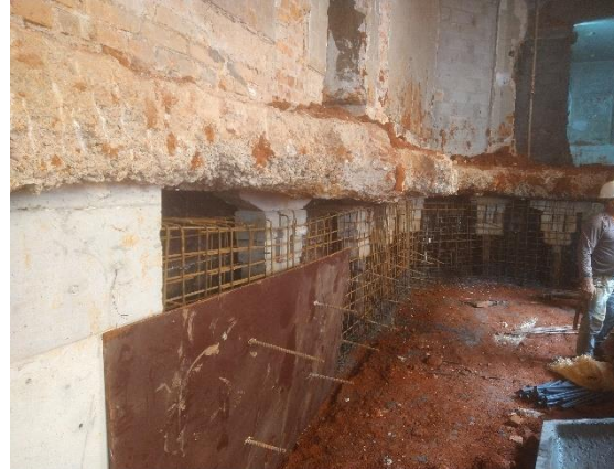
Figura 10. Parede de concreto envolvendo as estacas mega abaixo de alvenaria interna.
