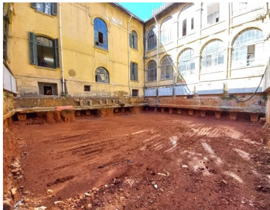
Figura 5. Estacas mega apoiando a fachada de uma das edificações.
