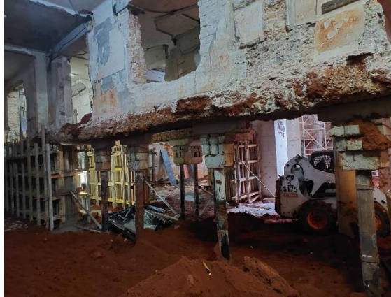
Figura 9. Estacas mega para apoio de alvenarias internas.
