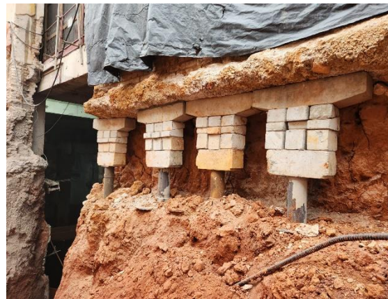
Figura 6. Detalhe dos blocos para encunhamento das estacas.
