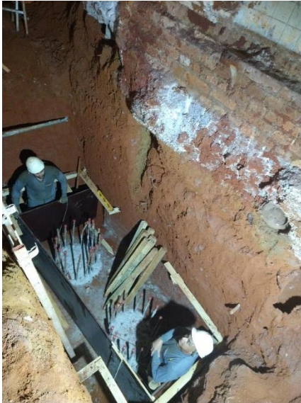
Figura 2. Arrasamentos dos tubulões de fundação do muro de arrimo interno.
