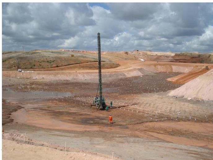
Figura 10. Visão geral da cravação dos geodrenos
