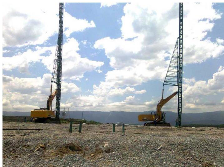
Figura 8. Instalação de geodreno com escavadora hidráulica
