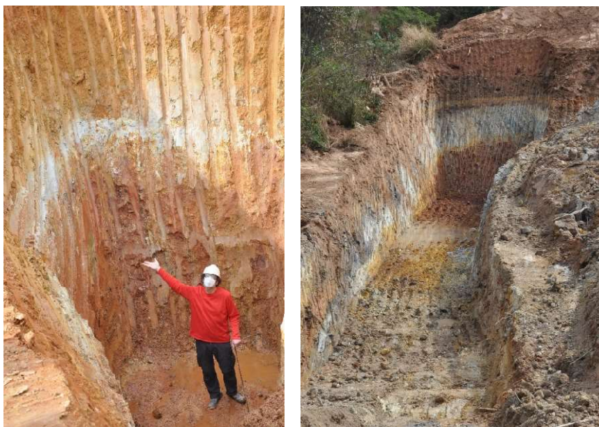
Figuras 2 e 3 – Abertura de poços para retirada de blocos indeformados e vista da escavação inicial da fundação do muro.
