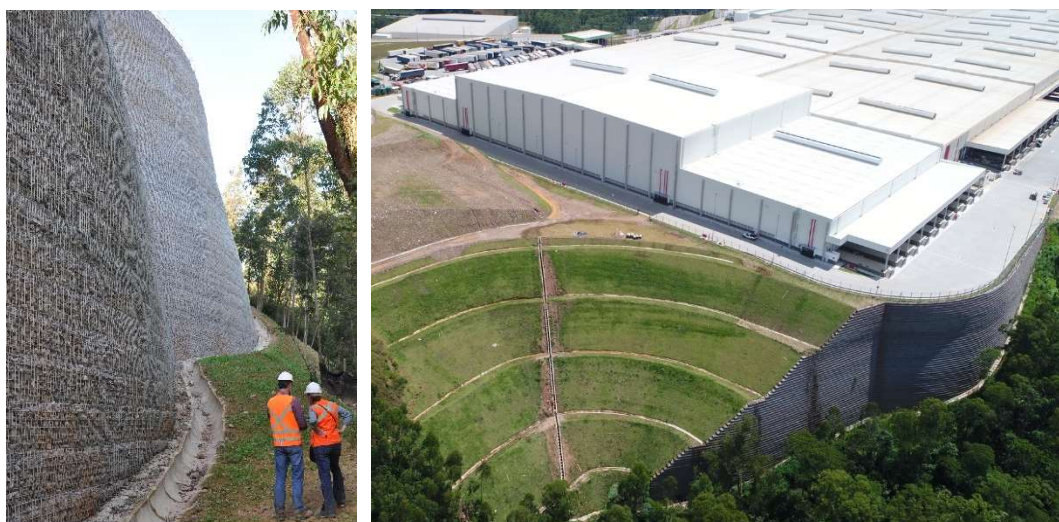
Figuras 12 e 13 – Fase final da obra com vista da face e vista de drone da obra finalizada.
