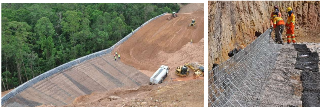
Figura 10 – Fase intermediária da obra com instalação de geogrelhas e espalhamento de aterro. Figura 11 – Detalhe da montagem da face.
