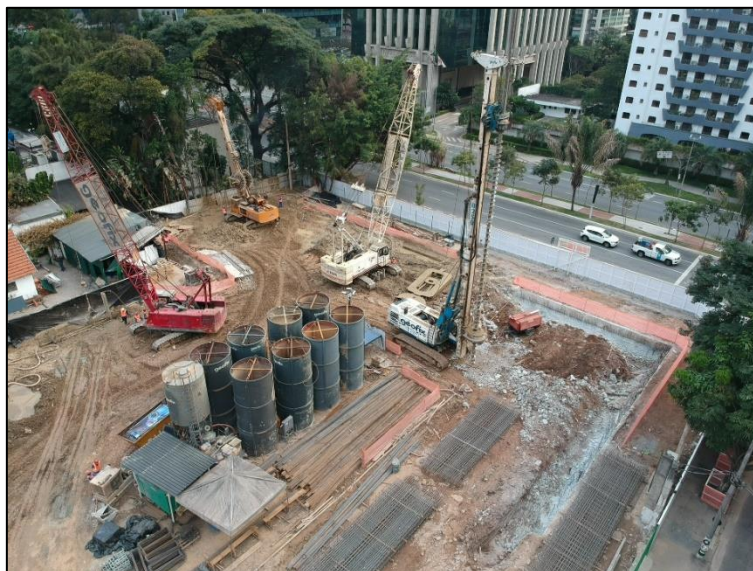
Figura 3. Execução de parede diafragma na edificação
