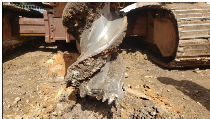
Figura 2. Ponteira com BIT's utilizada para execução de pré-furos
