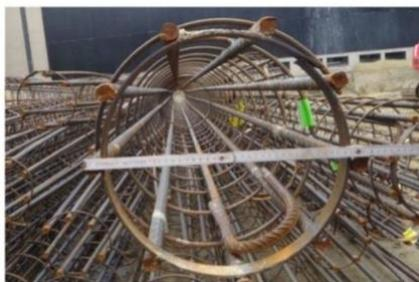
Figura 7. Armação empregada nas estacas secantes (FLEURY, 2012)
