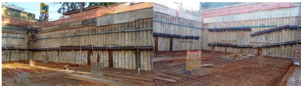
Figuras 10 e 11. Visão geral da obra durante a etapa de armação da laje de subpressão com detalhe para a armadura do pilar de divisa (autoria própria)
