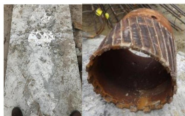
Figuras 4 e 5. Vista superior do detalhe da interseção de estacas secantes (autoria própria) e Detalhe da ponta do tubo (FLEURY,2012)
