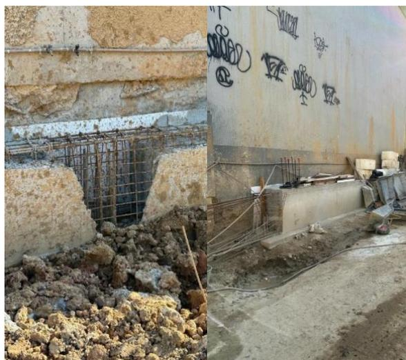
Figuras 8 e 9: Trecho da viga de coroamento das estacas secantes com detalhe para o preparo para recebimento da armadura do pilar existente na periferia (autoria própria) e Trecho da viga de coroamento das estacas secantes com detalhe para o arranque da armadura do pilar instalada
