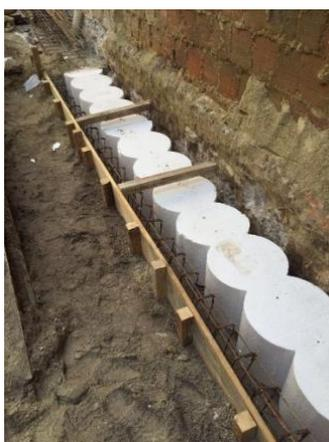
Figura 2. Forma de isopor identificada e com a mureta concretada (autoria própria)
