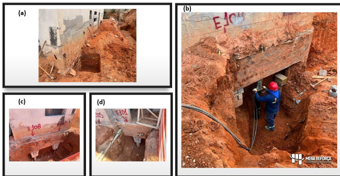
Figura 8. Execução das estacas mega na obra
