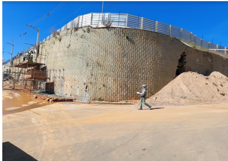
Figura 5. Início dos serviços de perfuração
