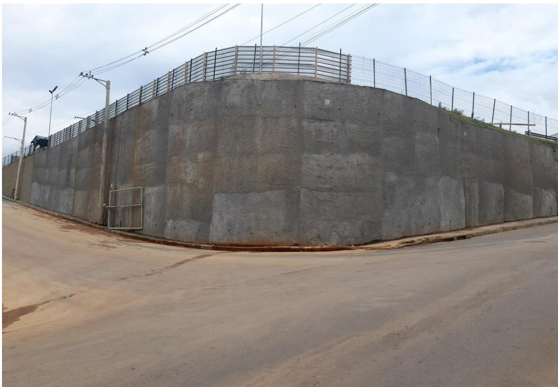
Figura 08: Contenção após a aplicação do concreto projetado
