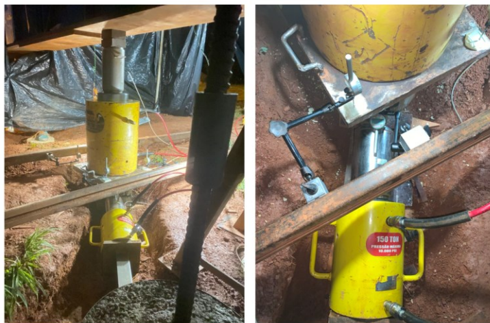
Figura 6. Sistema de aplicação de carga horizontal da estaca T3.
