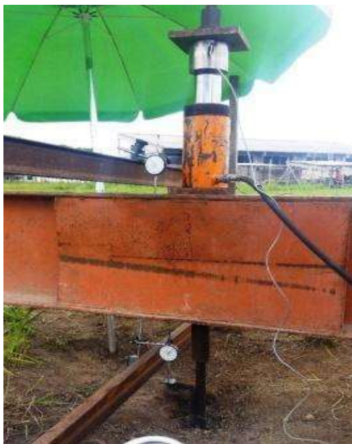
Figura 4. Ligação da estaca ET-1 com a luva metálica, o perfil metálico e o macaco hidráulico vazado (Filho, 2016).
