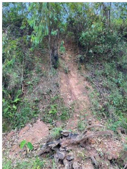
Figura 3 – Talude experimental antes do plantio do bambu Fonte: Os autores
