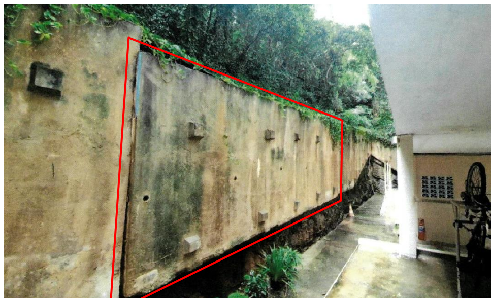
Figura 1. Segmento da cortina atirantada em análise (contornos em vermelho)
