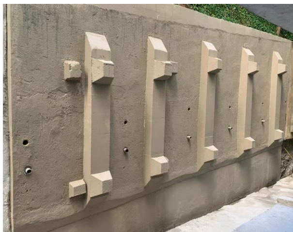
Figura 11. Cortina atirantada recuperada
