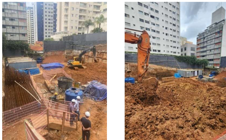
Figura 15. Escavação de parte do terreno até a primeira linha de tirantes
