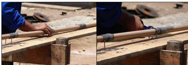
Figura 4. Montagem comum das válvulas manchete em canteiros de obras
