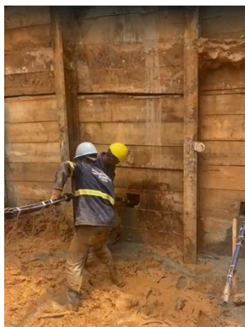
Figura 16. Instalação dos tirantes montados em fábrica
