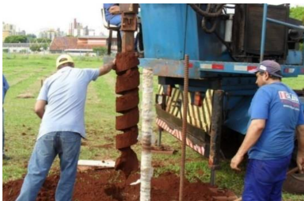
Figura 3. Perfuração de estaca escavada sem fluido estabilizante. Fonte: ALMADA, 2016.
