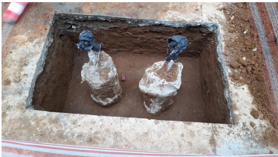
Figura 7. Escavação do bloco após finalização da Microestaca
