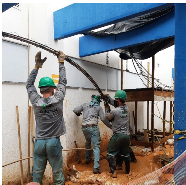
Figura 5. Instalação da armadura
