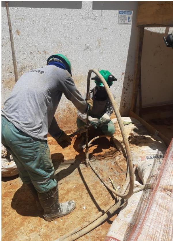
Figura 6. Injeção através do tubo mancheteado
