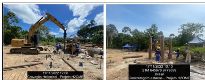
Figura 9 - Cravação e Concretagem das Estacas. (Acervo Interno Elecnor do Brasil)
