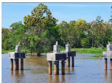
Figura 1 - Bloco Sobre Estacas - Área Alagada
