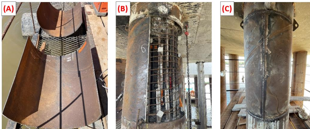
Figura 11. (A) Duas metades da camisa de aço a utilizar na recomposição, com (B) a primeira metade da camisa já soldada à estaca e (C) solda da segunda metade para fechamento do tubo de aço.
