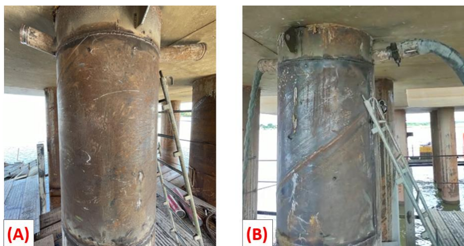
Figura 12. (A) Aberturas com tubos criadas para injeção e expurgo de concreto e (B) momento da concretagem, com detalhe do expurgo saindo por um dos furos.
