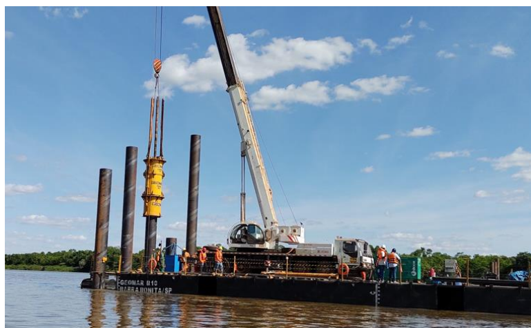
Figura 3. Estacas tubulares de aço cravadas nos apoios centras (região da calha do rio Araguaia)
