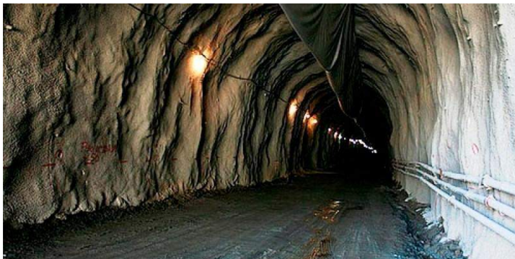
Figura 4 - Interior do Túnel Cuncas I, entre os estados da Paraíba e do Ceará.
