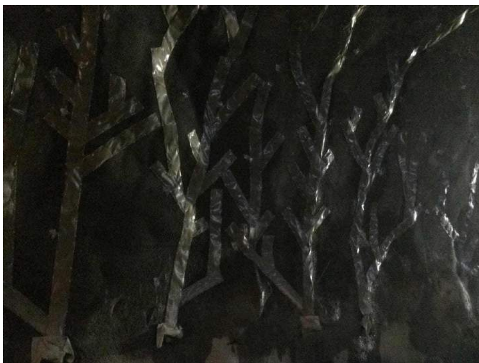
Figura 5 - Drainpacks instalados gerando um caminho para água. Fonte: o Autor (2019).
