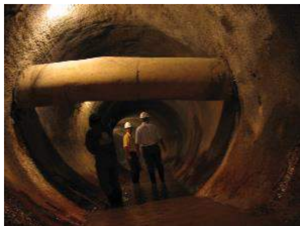
Foto 16 - Caso 10 – Detalhe do oleoduto Orbel e janela/Oleoduto Orbel encamisado e protegido da seção do túnel
