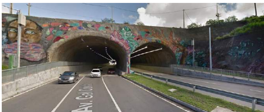
Figura 16 - Emboques dos túneis 3ª à direita e 3B à esquerda no emboque sentido Aeroporto, para a direita sentido proveniente do Aeroporto. (Projeto Maffei, 2017).
