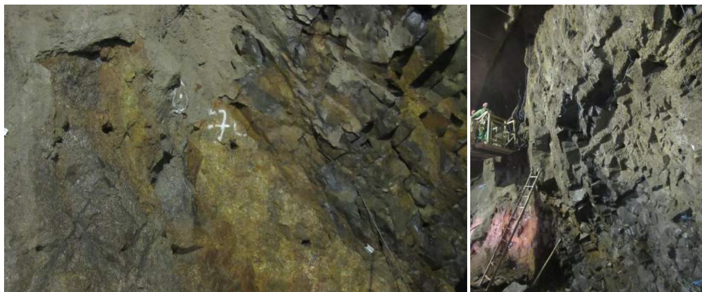
Figura 5 - Trecho do túnel com afloramento de dique de rocha básica na frente de escavação. Notar padrão de fraturamento frequente e persistente, planos oxidados e alterados em meio a material são ou pouco alterado. Região próxima ao contato com a rocha encaixante.
