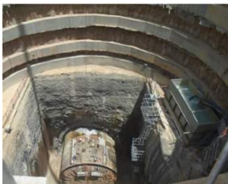
Figura 10 - Pozo sur de salida de TBM (SAS)
