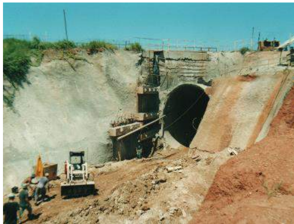
Foto 1 - Caso 1 - Túnel ferroviário em Aguiarnópolis/TO – Seção útil 52,2 m 2 – Comprimento 69,0 m
