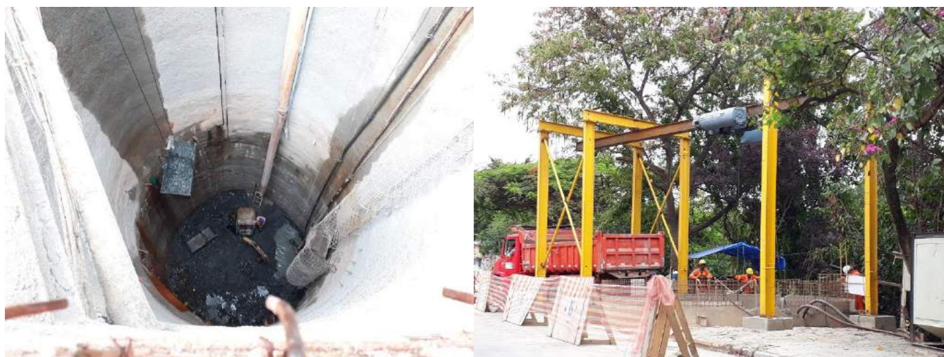
Figura 8 - (a) Retirada do material de escavação através de caçambas (b) vista da ponte rolante a partir da superfície. (Fonte: ATO GeoCompany)
