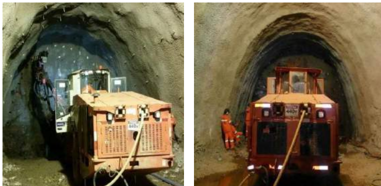
Figura 10 - Execução dos furos do plano de fogo
