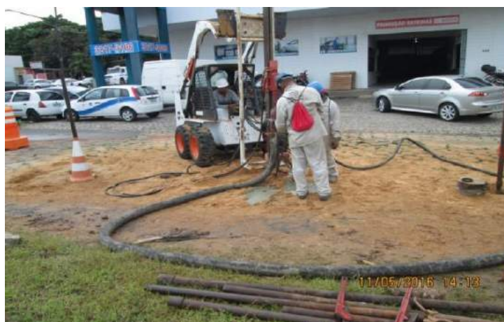
Figura 15 - Aplicação Jet Grouting (Vertical). Fonte: autor.
