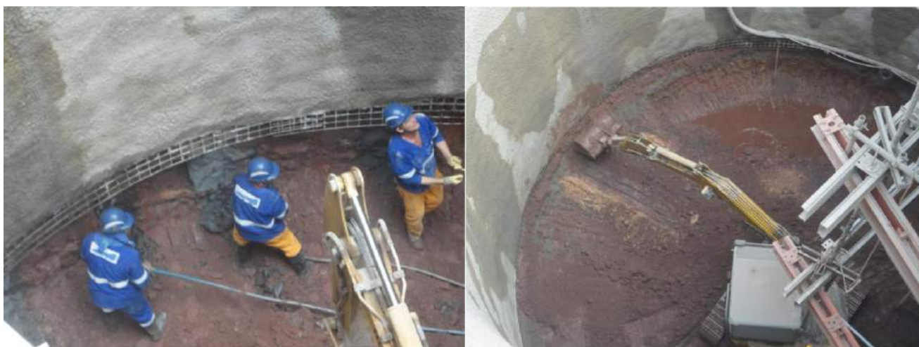
Figura 7 - Detalhe do poço 1 (a) instalação da tela metálica da armação sendo possível observar a descontinuidade das colunas de JG e (b) escavação em solo siltoso coesivo. (Fonte: ATO GeoCompany)
