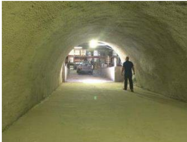
Foto 7 - Caso 7 - Túnel para interligação de depósitos em supermercado São Paulo/SP - Diâmetro 5,50 m - Comprimento 15,60 m
