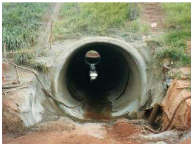
Foto 2 - Caso 2 - Túnel para drenagem – Araraquara/SP – Seção útil 23,0 m 2 – Comprimento 81,5 m
