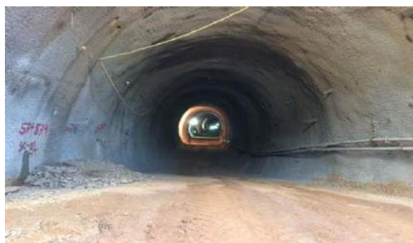
Figura 9 - Aspecto final do concreto projetado
