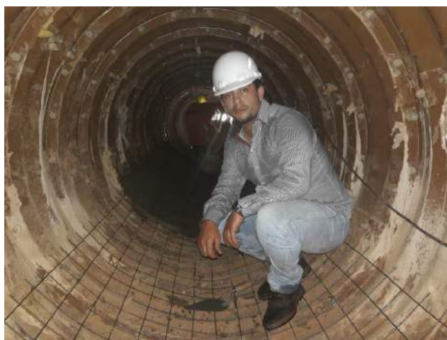
Figura 18 - Execução do berço de concreto. Fonte: autor.
