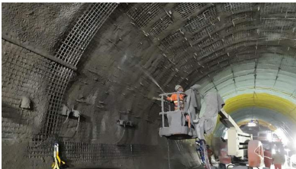
Foto 5 - Camadas finais de concreto projetado, seguindo metodologia com malhas de projeção e conclusão de todas as camadas em prazo máximo de 72 horas
