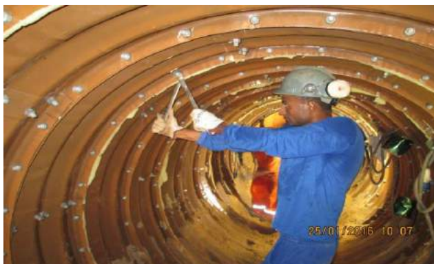
Figura 10 - Montagem da ligação entre as chapas. Fonte: autor.
