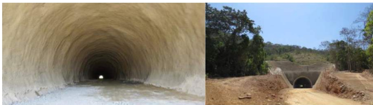
Figura 12 - Túnel Antônio Dias - Visão geral
