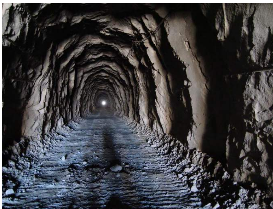
Figura 2 - Interior do Túnel do Eixão das Águas após a escavação inicial. Fonte: COGERH (2014).
