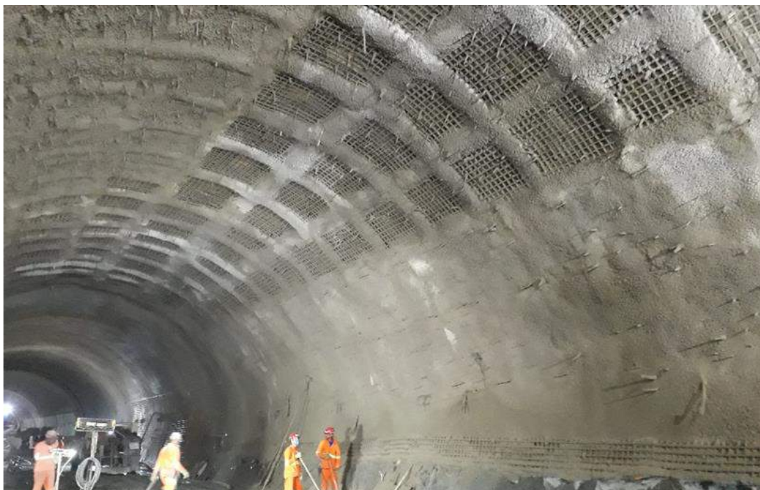
Foto 3 - Projeção das primeiras camadas de concreto em malhas e panos de pequena extensão
