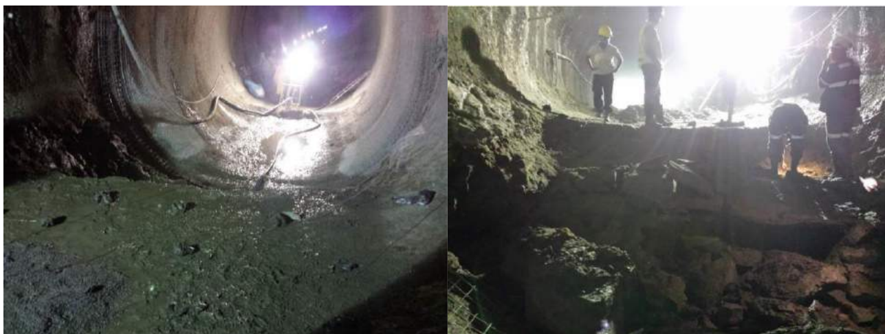
Figura 14 - Vista de escavação de arco invertido em rocha em (a) durante carregamento para desmonte de rocha e (b) maciço rochoso detonado. (Fonte: ATO GeoCompany)
