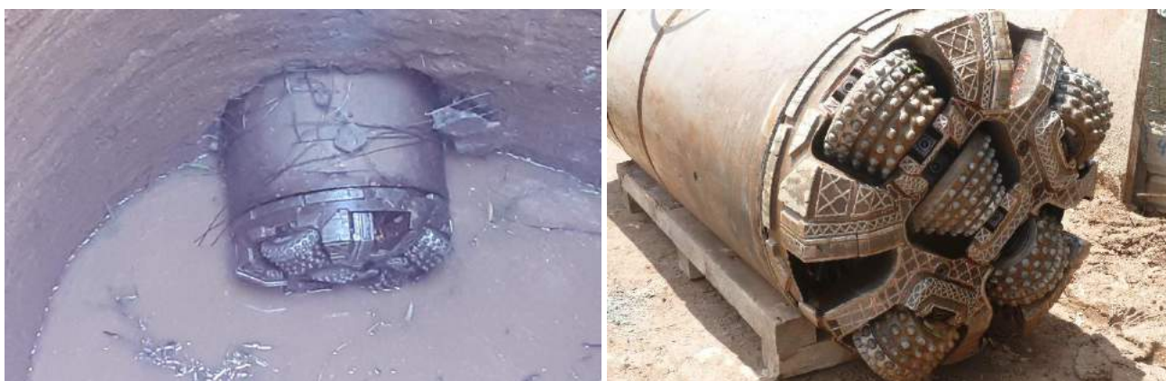
Figura 2 - Máquina AVN800 para rocha após conclusão de um dos trechos
