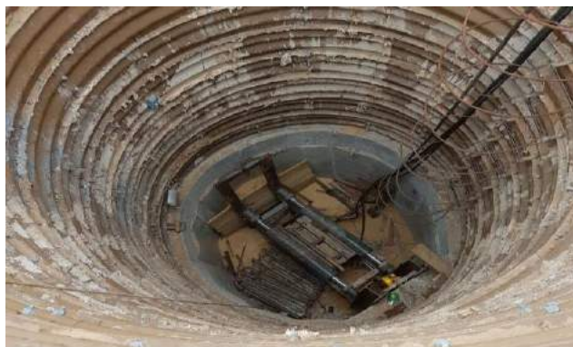
Figura 16 - Execução do Tubo Tracionado (Jusante). Fonte: autor.
