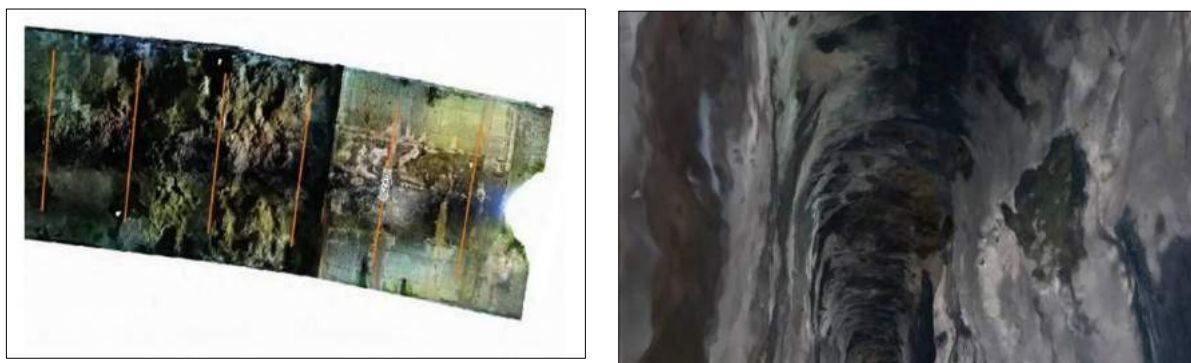
Figura 2 – à esquerda, mosaico de imagens do laser scanner , região da abóboda do T2, onde ocorria maior concentração de desprendimento de blocos. À direita, imagem com destaque para locais com desprendimento do concreto projetado
