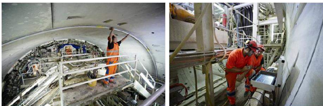
Figura 9 - Instalação de SAA de convergência próxima à face de escavação
