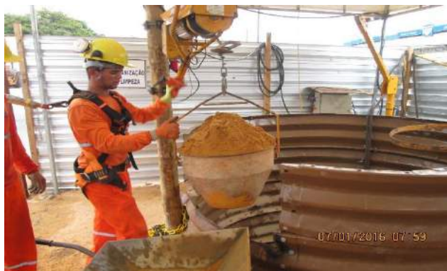
Figura 9 - Execução da retirada do material pelo poço de visita. Fonte: autor.
