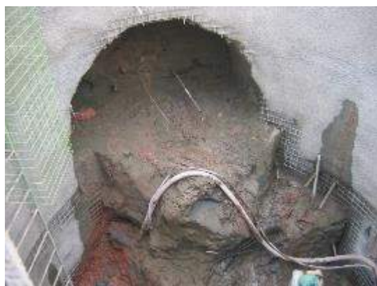
Foto 11 - Caso 10 – Vista do poço de acesso e emboque do túnel
