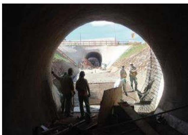
Foto 5 - Caso 5 - Túneis para pedestres – Brasília/DF – Diâmetro 4,40 m – Comprimento 44,0 m
