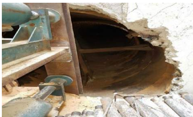
Figura 17 - Execução do Tubo Tracionado (Jusante). Fonte: autor.
