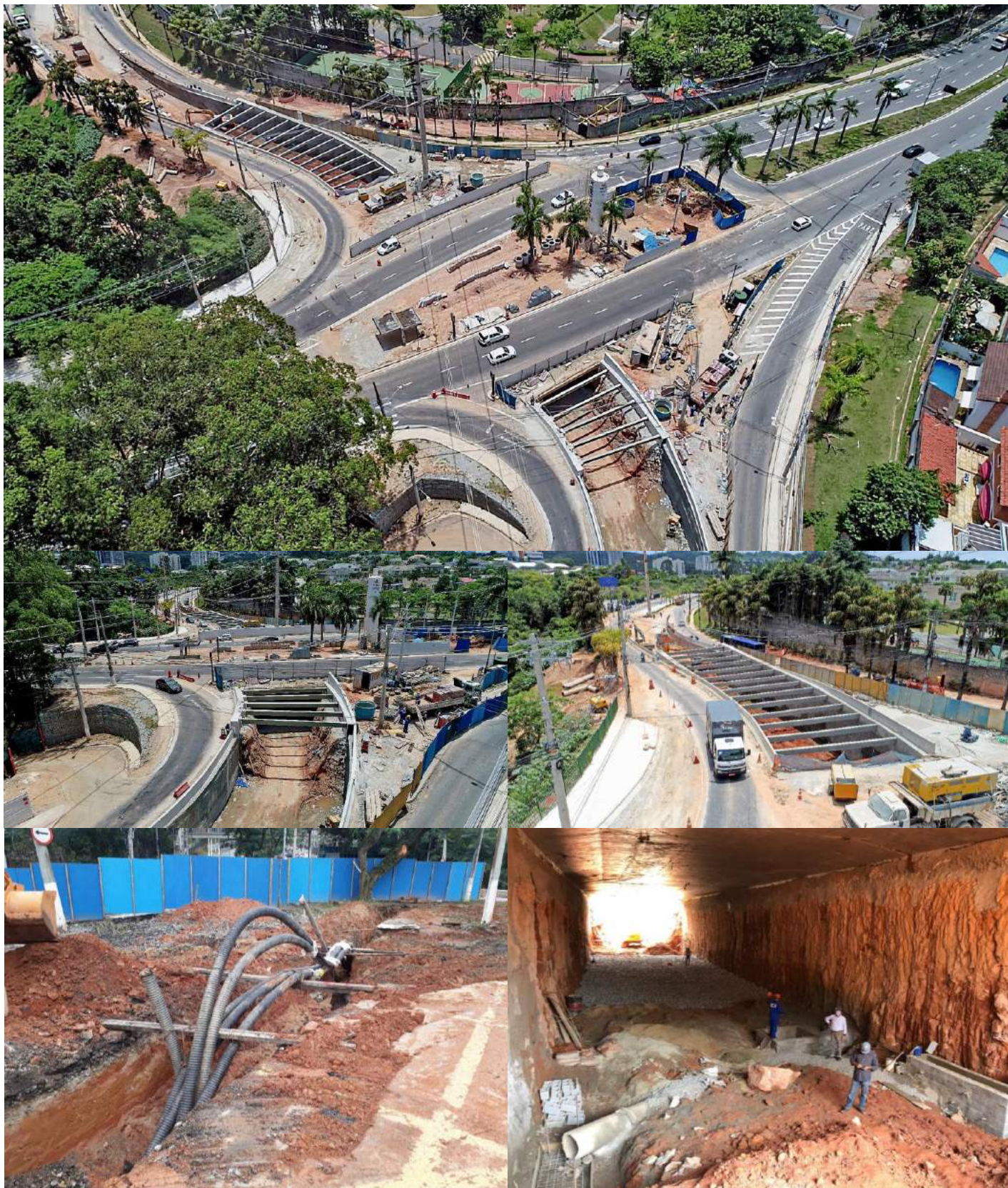
Figura 11 - Fotos da obra durante execução
