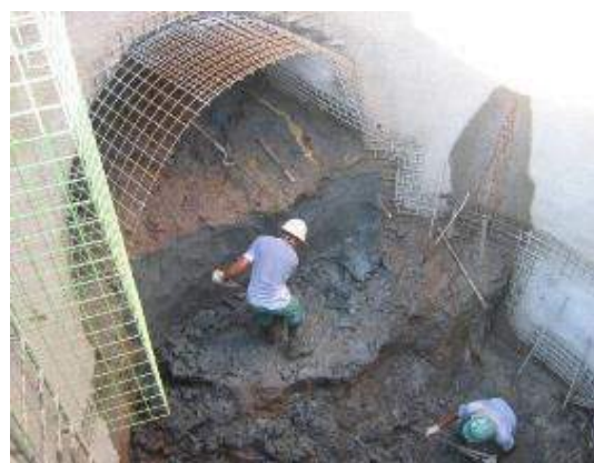
Foto 11 - Caso 10 – Vista do poço de acesso e emboque do túnel
