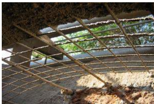
Foto 17 - Caso 10 – Detalhe da janela no teto e baixa cobertura do túnel
