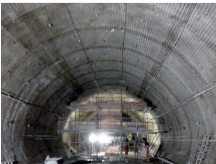
Foto 4 - Instalação da segunda camada de tela metálica
