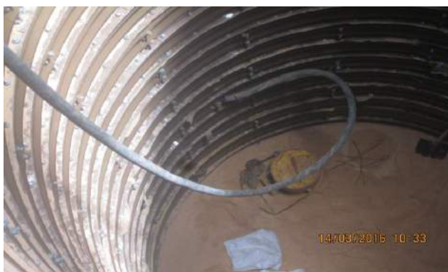
Figura 11 - Injeção de argamassa. Fonte: autor.
