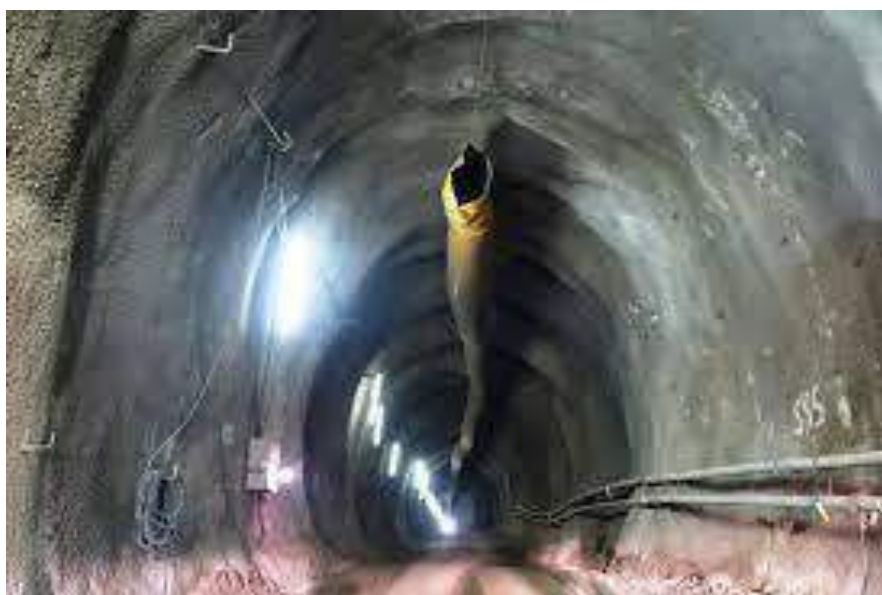
Figura 1 - Interior do Túnel Veneza, em Missão Velha (CE). Fonte: Gazeta do Cariri. (2017).
