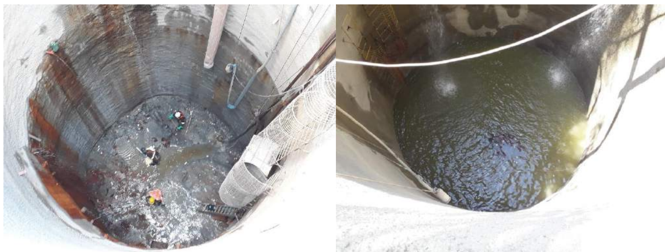
Figura 7 - (a) instalação dos explosivos para desmonte e (b) poço preenchido com água antes da detonação. (Fonte: ATO GeoCompany)
