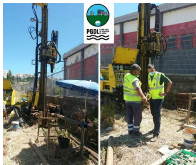
Figuras 18 e 19 - Campanha de sondagens complementares na zona TM1; Acompanhamento dos trabalhos de campo pela EPPGDL (Fonte: EPPGDL)
