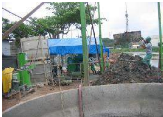
Foto 10 - Caso 10 – Poço de acesso ao túnel – Retirada do material escavado em caçambas
