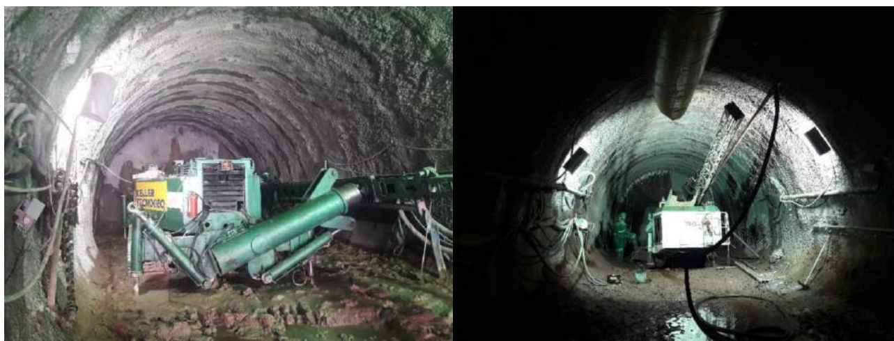
Figura 12 - (a) Execução de tratamento em colunas de CCPH e (b) execução de tratamento através de enfilagens. (Fonte: ATO GeoCompany)
