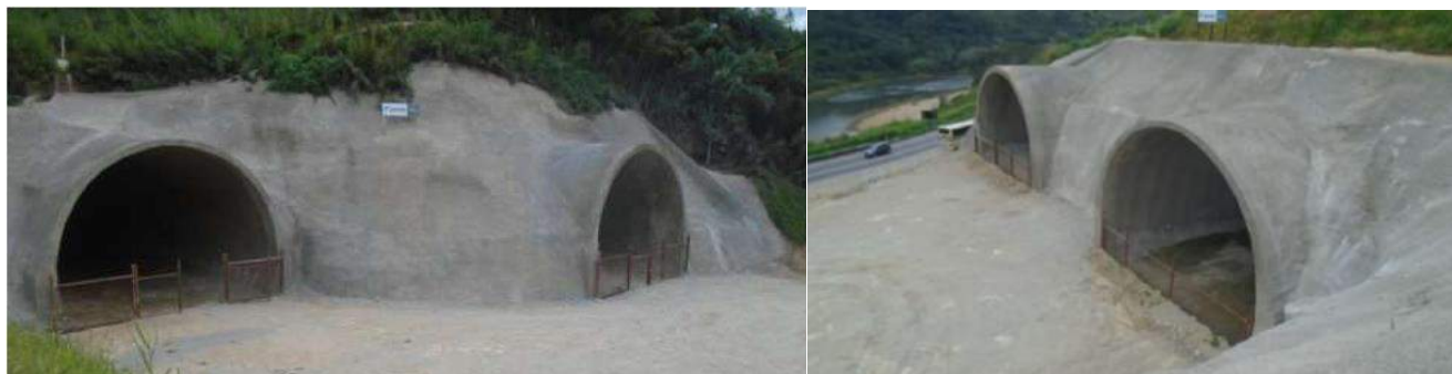
Figura 10 - Túnel Rio Piracicaba - Emboque Governador Valadares
