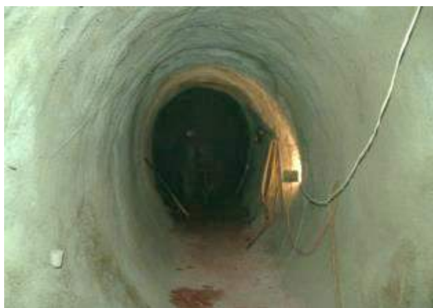
Foto 4 - Caso 4 - Túnel para acesso a elevador em Residência no Pacaembu, São Paulo/SP – Seção útil 6,0 m 2 – Comprimento 22,0 m
