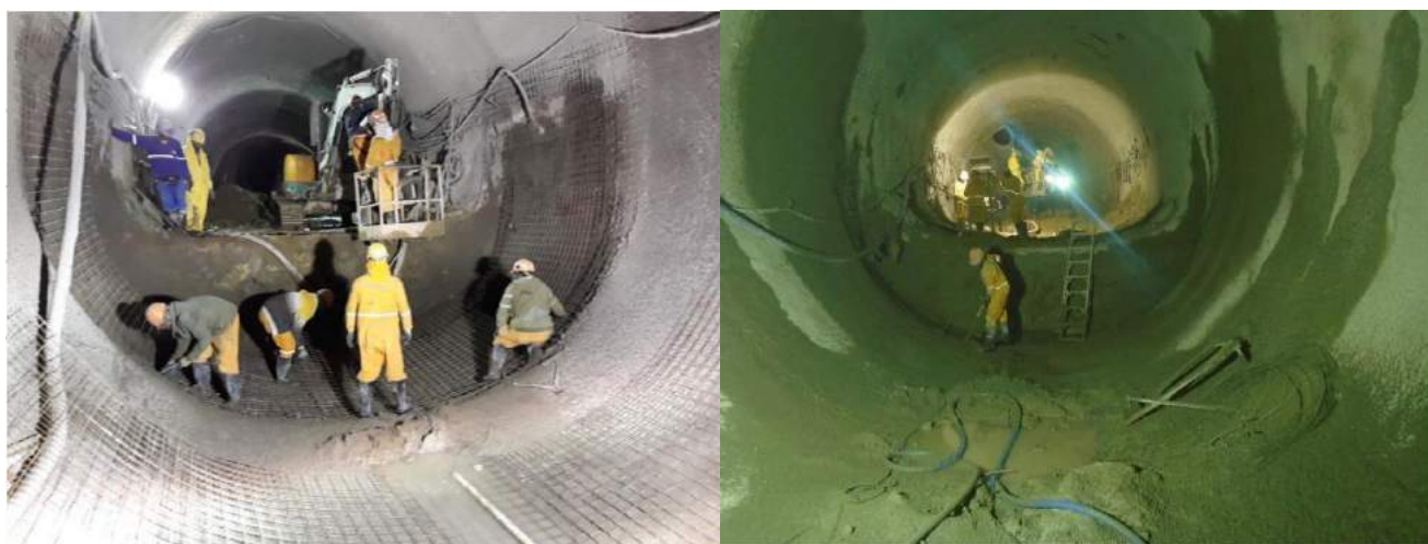
Figura 15 - (a) instalação da armadura para concretagem ao arco invertido definitivo e (b) trecho do túnel com AID já concluído. (Fonte: ATO GeoCompany)
