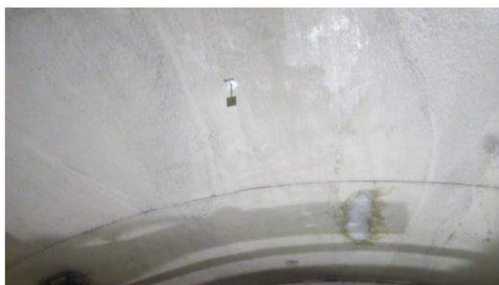
Figura 7 - (a) Marco reflexivo instalado no teto do túnel para medição de convergência e (b) Fissurômetro para acompanhamento de abertura de fissura
