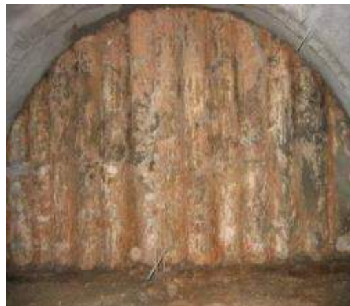
Foto 20 - Caso 10 – Término da escavação e encontro da parede de estacas justapostas
