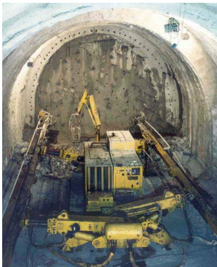
Figura 6 - Máquina de perfuração direcional em túnel escavado pelo método ADECO-RS (LUNARDI et al. , 2015b).
