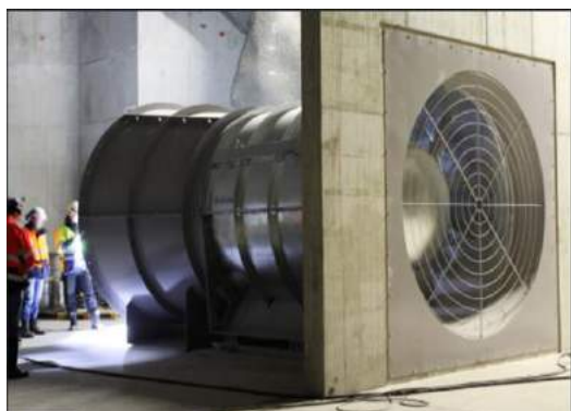
Figura 10 e 11 - Detalhes ilustrativos do jato ventilador e disposição em relação à câmara dos ventiladores
