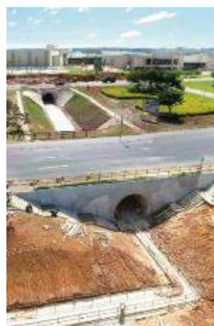
Foto 5 - Caso 5 - Túneis para pedestres – Brasília/DF – Diâmetro 4,40 m – Comprimento 44,0 m
