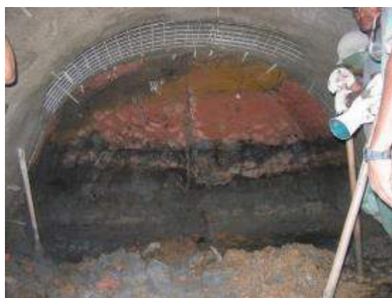
Foto 12 - Caso 10 – Frente escavada com enfilagens cravadas
