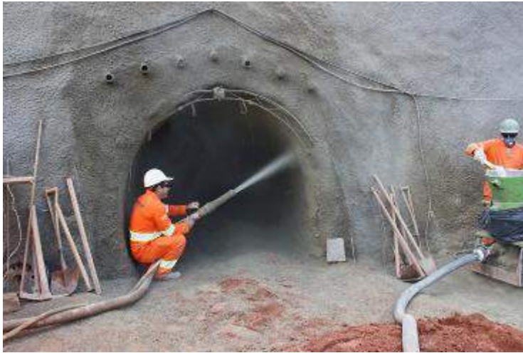
Foto 6 - Caso 6 - Túnel para drenagem - Queluz/SP - Diâmetro 1,80 m - Comprimento 53,50 m
