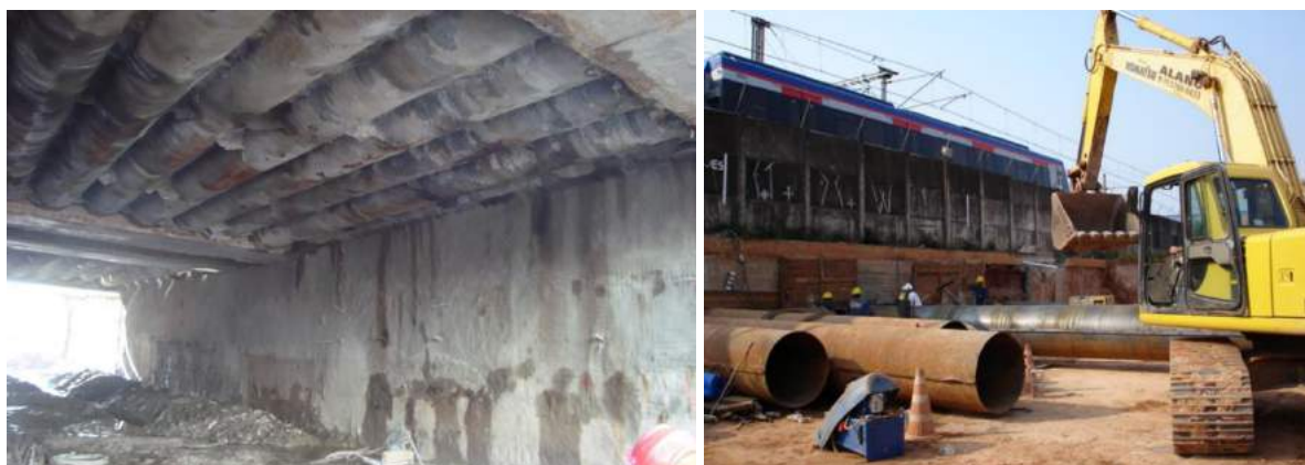
Figura 12 - (a) Estrada da Batalha – Recife, PE - Pré-laje com tubos preenchidos por concreto armado (Projeto Maffei, 2009); (b) Radial Leste – São Paulo, SP –Instalação de tubos antes do procedimento de concreto armado sob o Metrô (Projeto Maffei, 2013).
