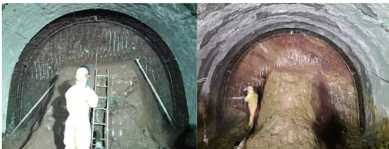
Figura 11 - Fotos da frente de escavação que foi executada mantendo o núcleo central. (Fonte: ATO GeoCompany)
