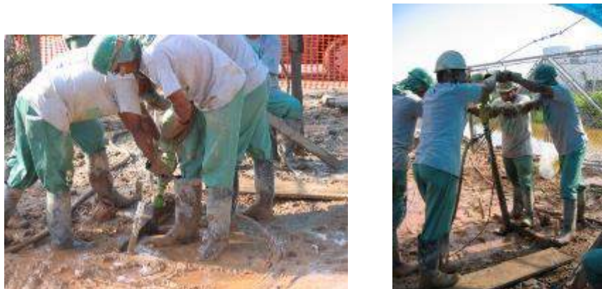
Foto 14 - Caso 10 – Perfuração para instalação de tubos para injeção
