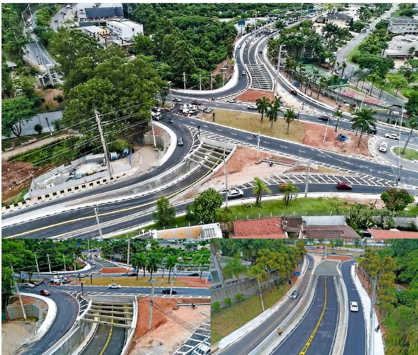
Figura 2 - Fotos da obra finalizada
