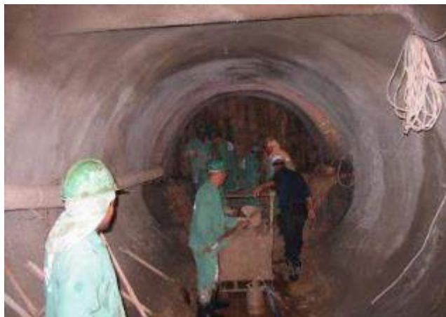
Foto 20 - Caso 10 – Término da escavação e encontro da parede de estacas justapostas
