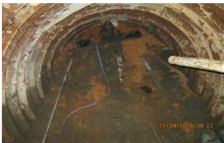
Figura 14 - Aplicação Jet Grouting - Tunnel (Horizontal). Fonte: autor.
