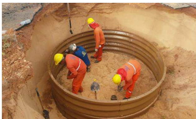
Figura 8 - Início da execução do poço de visita. Fonte: autor.
