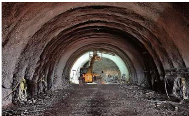
Figura 7 - Cambotas dos túneis do Ramal
