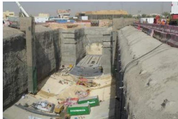
Figura 4 - Vista general del CLS con taludes en roca
