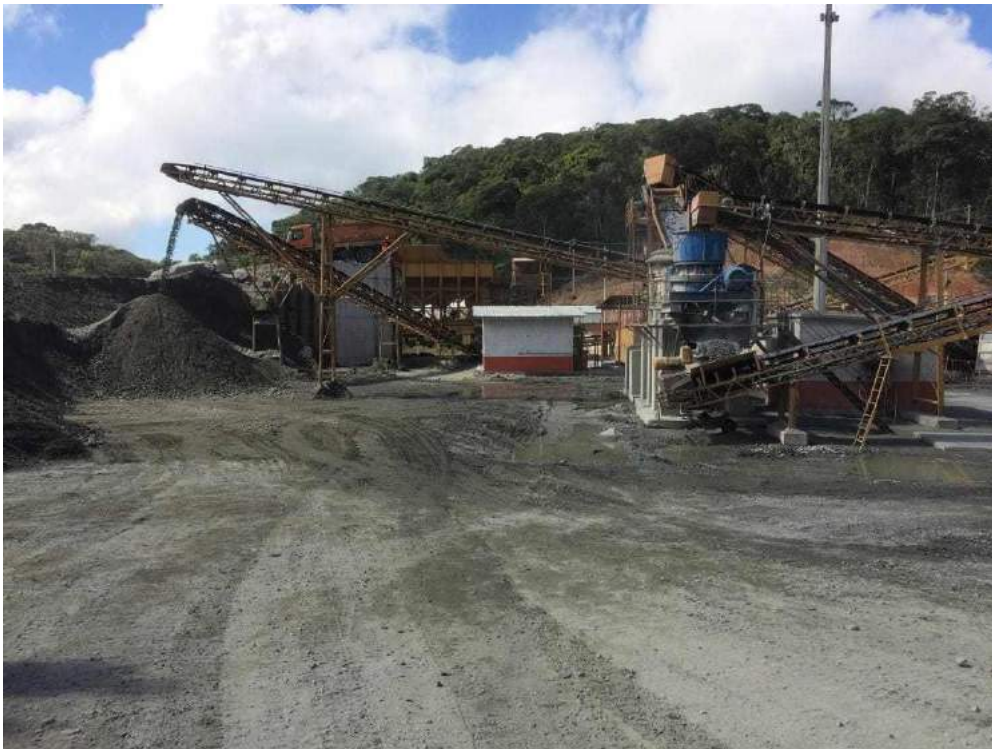
Figura 10 - Britador industrial no canteiro de obras. Fonte: o Autor (2019).
