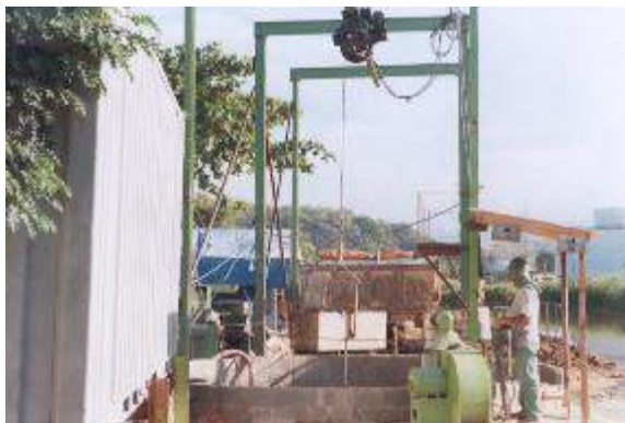
Foto 10 - Caso 10 – Poço de acesso ao túnel – Retirada do material escavado em caçambas
