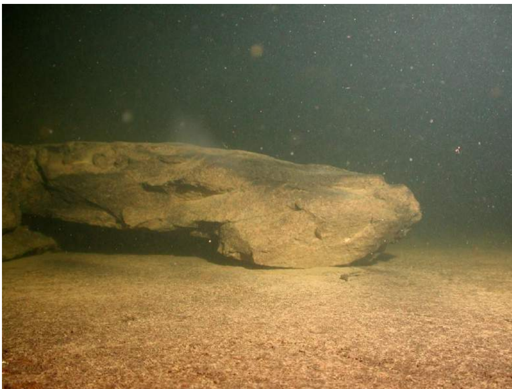
Figura 1 - Grande bloco de rocha encontrado no piso do túnel
