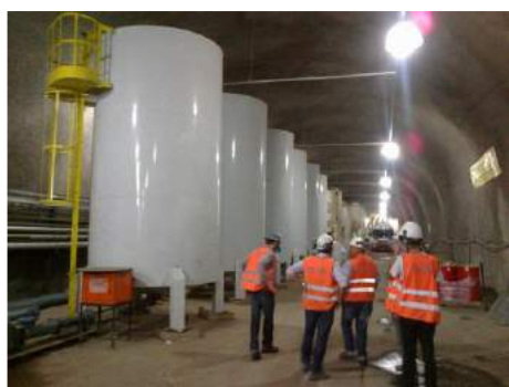
Figuras 05 e 06 - Silos de estocagem de calda ( slurry ) composta por bentonita e água e misturador, ambos no interior de túnel de apoio durante a execução da Linha 4 Sul do Metrô do Rio de Janeiro (arquivo pessoal)
