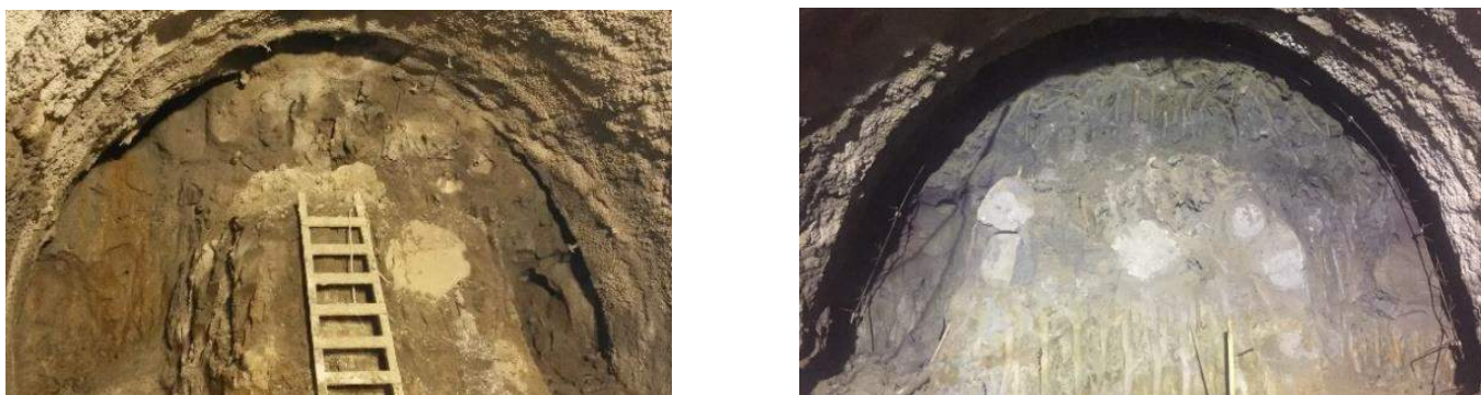
Figura 8 - Comparação dos aspectos geológico - geotécnicos das seções escavadas entre a 1ª Etapa (toda em aluvião e face instável) à esquerda, Novatecna 2018 e a 2ª Etapa (transição de aluvião para residual e face estável) à direita, Claret D. 2018.
