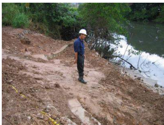
Foto 21 - Caso 10 – Vigas de encabeçamento no desemboque do canal tomada d'água
