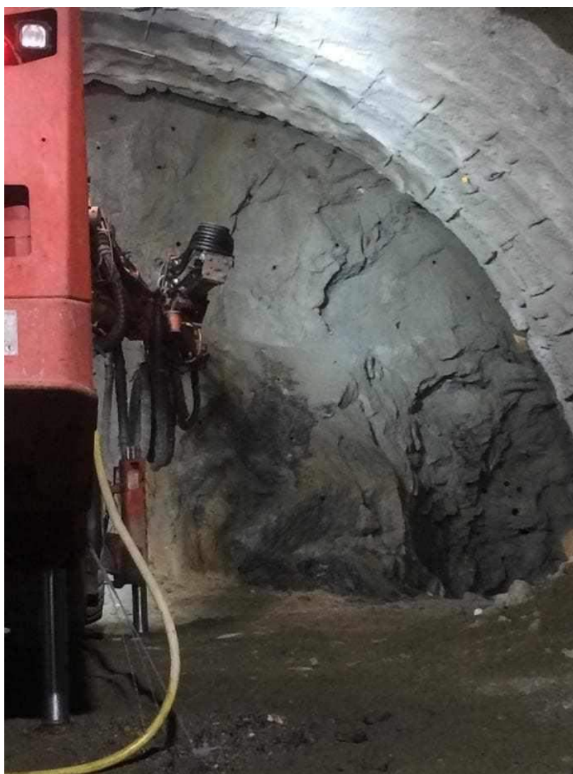
Figura 7 - Trecho de túnel escavado em meia seção com a utilização de cambota metálica. Fonte: o Autor (2019).
