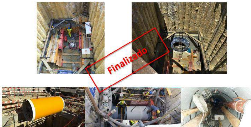
Figura 8 - Microtunelização: poços de entrada e saída da máquina (Fonte: Gomes T.A e Vieira G.D.)
